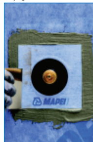
Укладання Mapeguard PC
