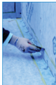
Укладання Mapeguard ST
