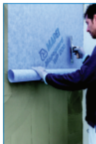
Укладання Mapeguard WP 200
