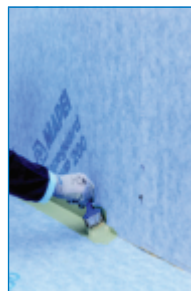
Нанесення Mapeguard WP Adhesive перед приклеюванням Mapeguard ST
