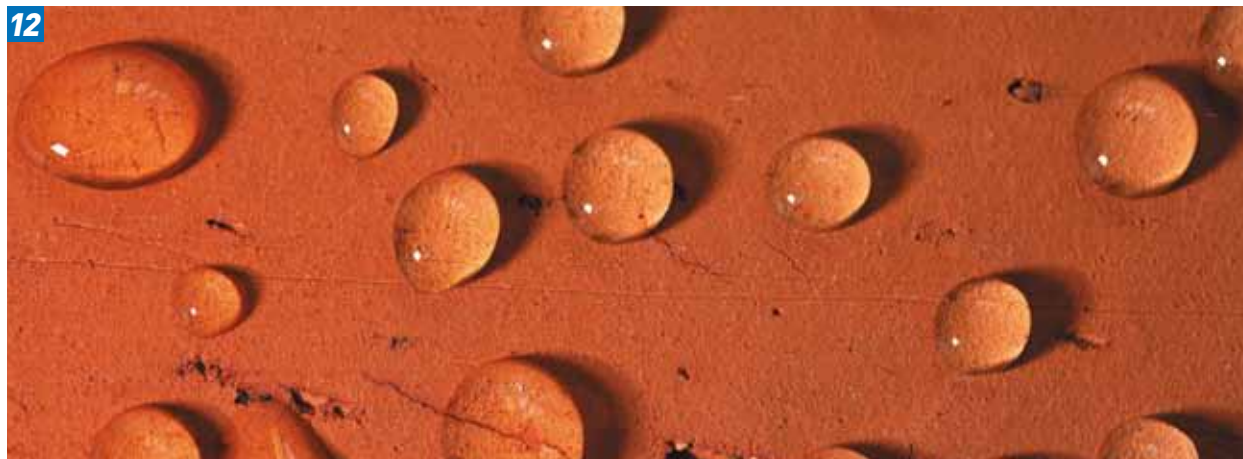
12. Parete trattata con Silancolor® Pittura Plus con tecnologia DropEffect®
