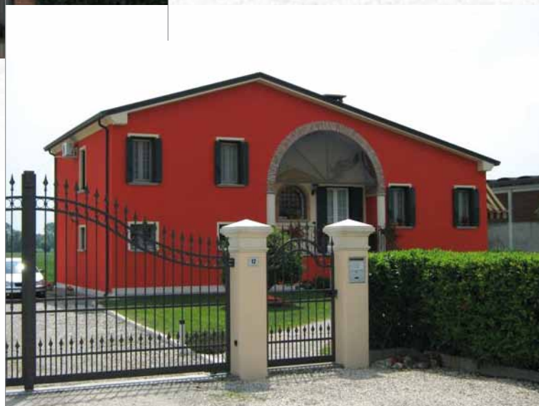
Esempio di edificio trattato con Silancolor® Tonachino Plus
