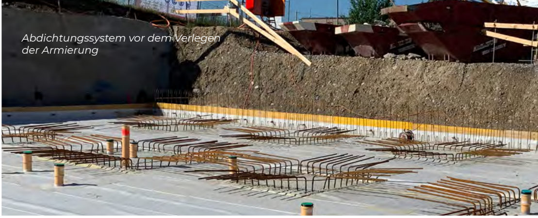
Baustelle mit Abdichtungssystem
