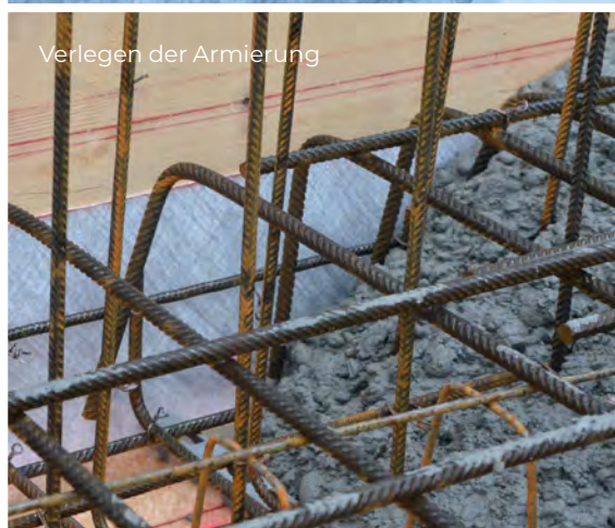
Abdichtung horizontaler Flächen
