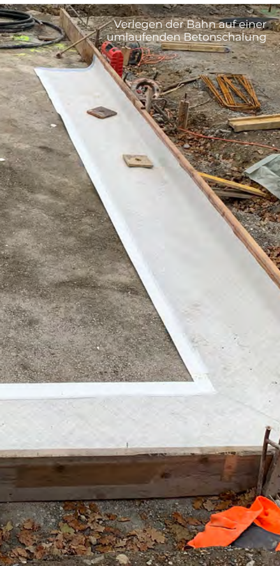
Abdichten eines Bohrpfahls
