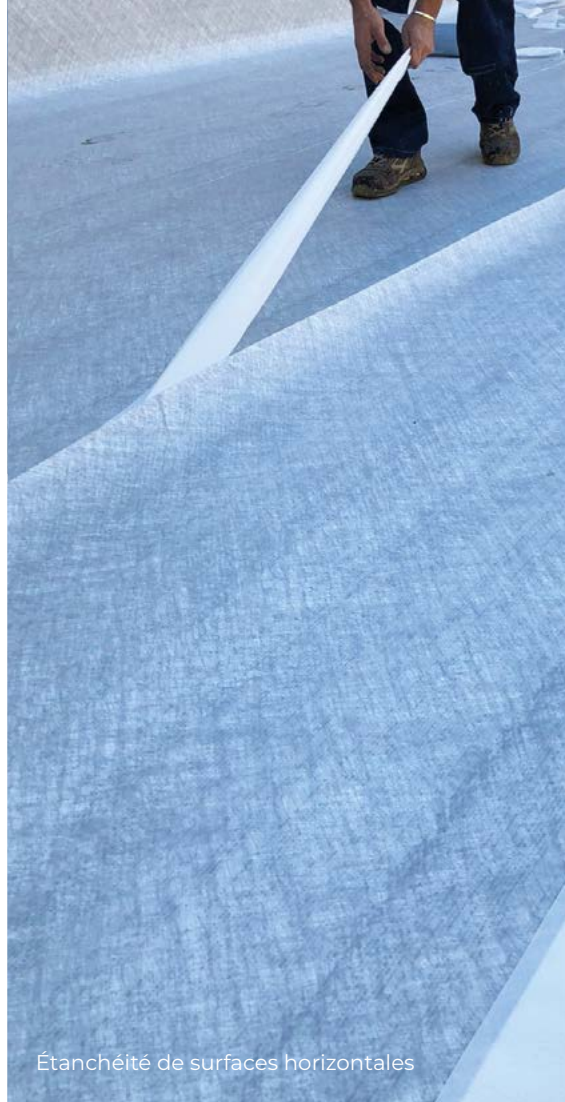
Pose de l'armature
