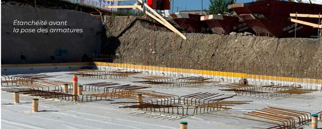
Chantier avec système d'étanchéité
