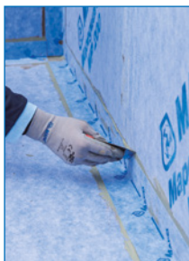
Auftrag von Mapeguard ST
