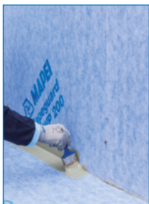
Auftrag des Klebemörtels Mapeguard WP Adhesive zur Verklebung von Mapeguard ST
