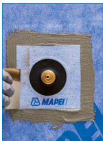
Auftrag von Mapeguard PC
