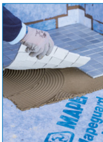
Verlegung von Glasmosaik auf Mapeguard WP 200
