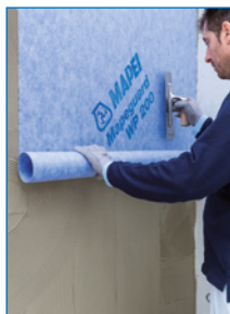
Verlegung von Mapeguard WP 200
