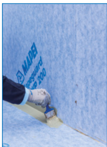
Application de l'adhésif bicomposant Mapeguard WP Adhesive pour coller Mapeguard ST
