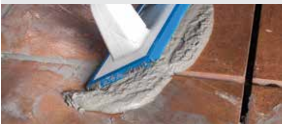
Verfugen der Keramik- und Natursteinplatten mit Ultracolor Plus
