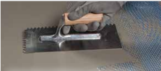
Einbetten von Mapenet 150 (Glasfasergewebe) in die erste Schicht Mapelastic Turbo
