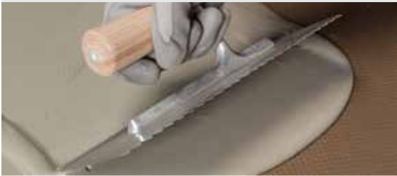
Auftragen der ersten Schicht Mapelastic Turbo
