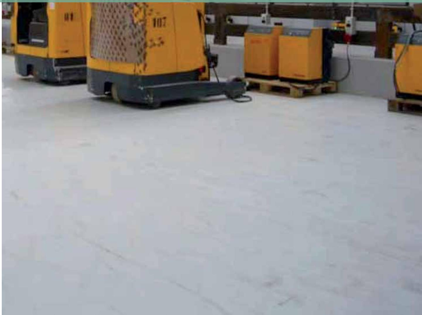
Gebrauchsfertige Hartstofffeinstreumischung auf Basis von Quarz, Zement und speziellen Zusatzstoffen.
