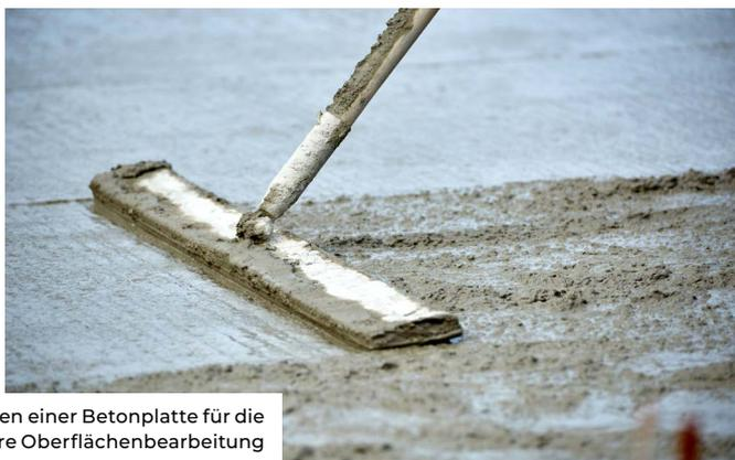
Abziehen einer Betonplatte für die spätere Oberflächenbearbeitung
