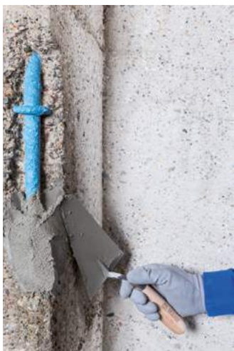
Auftragen von Planitop Rasa & Ripara R4 mit der Maurerkelle
