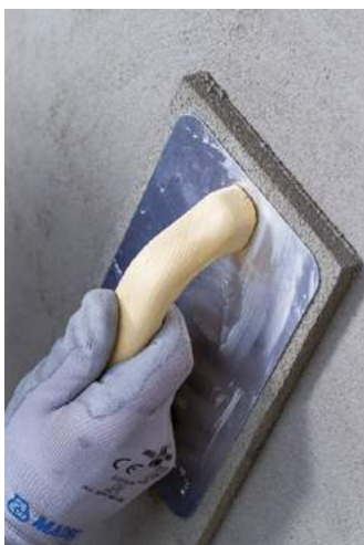
Bearbeiten von Planitop Rasa & Ripara R4 mit dem Schwammbrett
