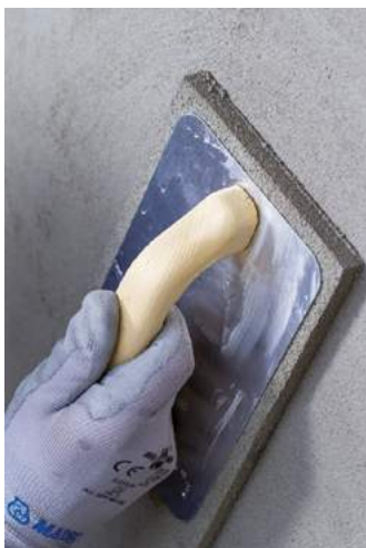
Finition de Planitop Rasa & Ripara R4 à la taloche éponge
