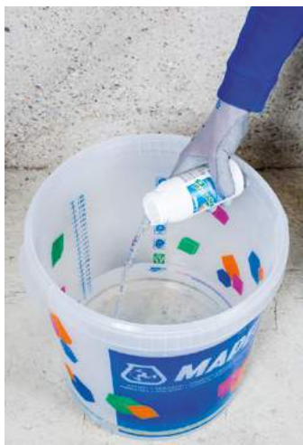
Ajout de Mapetard ES à l'eau de gâchage de Planitop Rasa & Ripara R4
