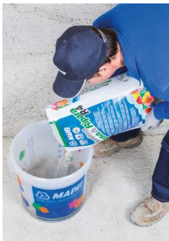
Ajout de Planitop Rasa & Ripara R4 à l'eau de gâchage additionné de Mapetard ES
