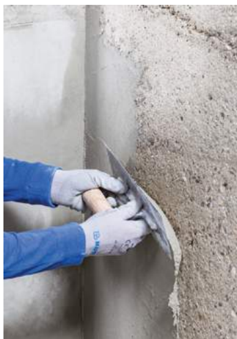
Application de Planitop Rasa & Ripara R4 à la spatule
