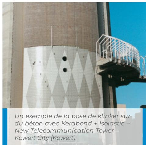
Un exemple de la pose de klinker sur du béton avec Kerabond + Isolastic – New Telecommunication Tower – Koweït City (Koweït)
