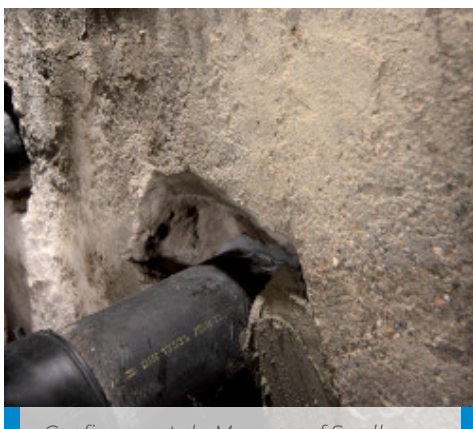
Confinement de Mapeproof Swell avec Mapegrout T 40
