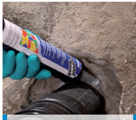
Appliquer Mapeproof Swell autour du tube
