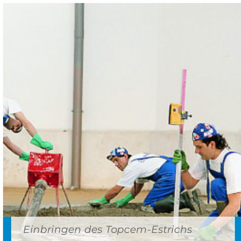
Anmischen von Topcem mithilfe einer automatischen Pumpeinheit
