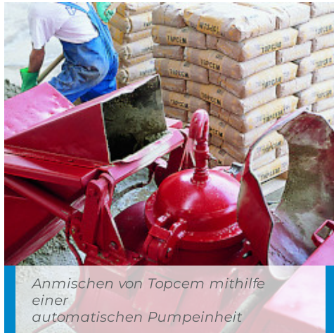
Förder des Topcem-Estrichmörtels mittels Estrichpumpe
