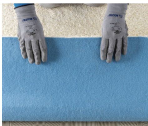
Verlegung von Tuftingbelag mit Vliesrücken
