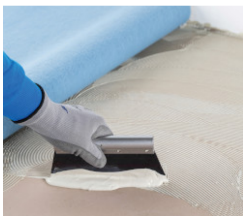
Auftrag von Ultrabond Eco TX1
