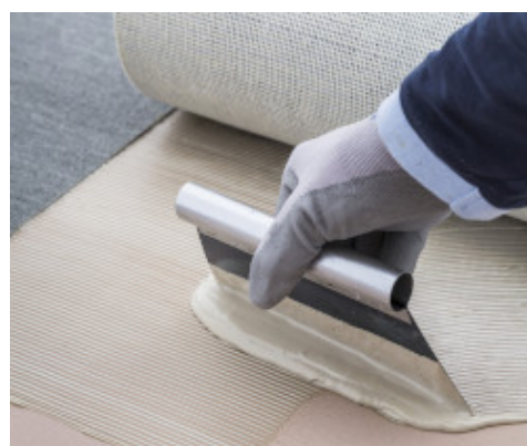
Verlegung von Tuftingbelag mit Action Back®
