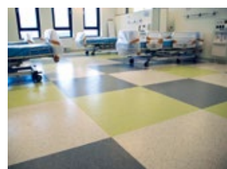
Die Verlegung des Gummibelags und der fertige Bodenbelag.
