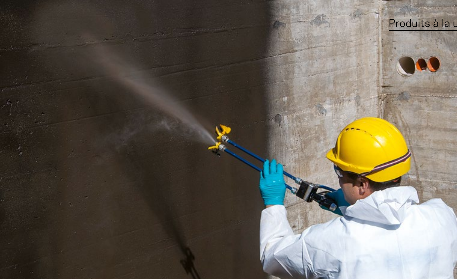
Auftrag einer Dickbeschichtung im Spritzverfahren.
