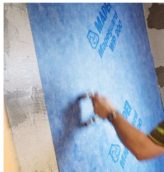
Die Wände wurden mit Mapeguard WP 200 und die Innenecken mit Mapeguard IC abgedichtet.
