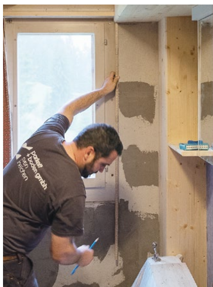
Im Badezimmer und in der Wohnküche wurden die Wände und Böden mit Eco Prim T grundiert.
