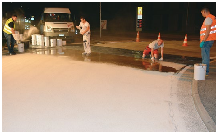
Die Arbeiten dauerten vom 17. Juli um 20 Uhr bis am 18. Juli um 6 Uhr. Les travaux ont duré du 17 juillet à 20 heures au 18 juillet à 6 heures.
