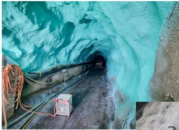
Impressionen der Spritzarbeiten von Mapelastic TU System.
