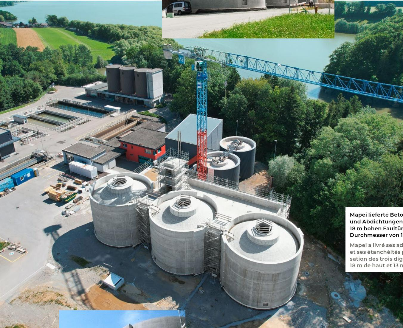
Mapei lieferte Betonzusatzmittel und Abdichtungen für die drei 18 m hohen Faultürme mit einem Durchmesser von 13 m.
