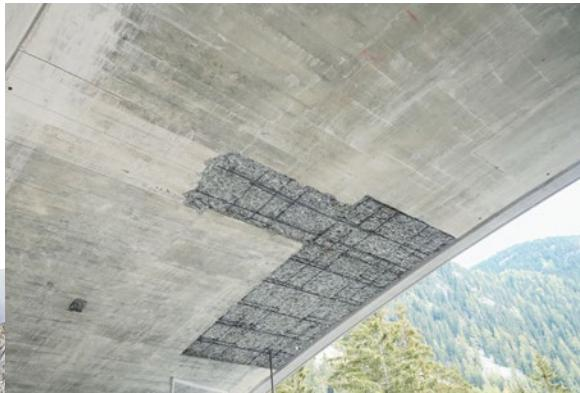
Um ein Stück Schweizer Bau-geschichte zu erhalten und den Beton fachgerecht instand zu setzen, hat Mapei ihren Korrosionsschutz Mapefer und ihren R4-Mörtel Mapegrout Tissotropico geliefert.
