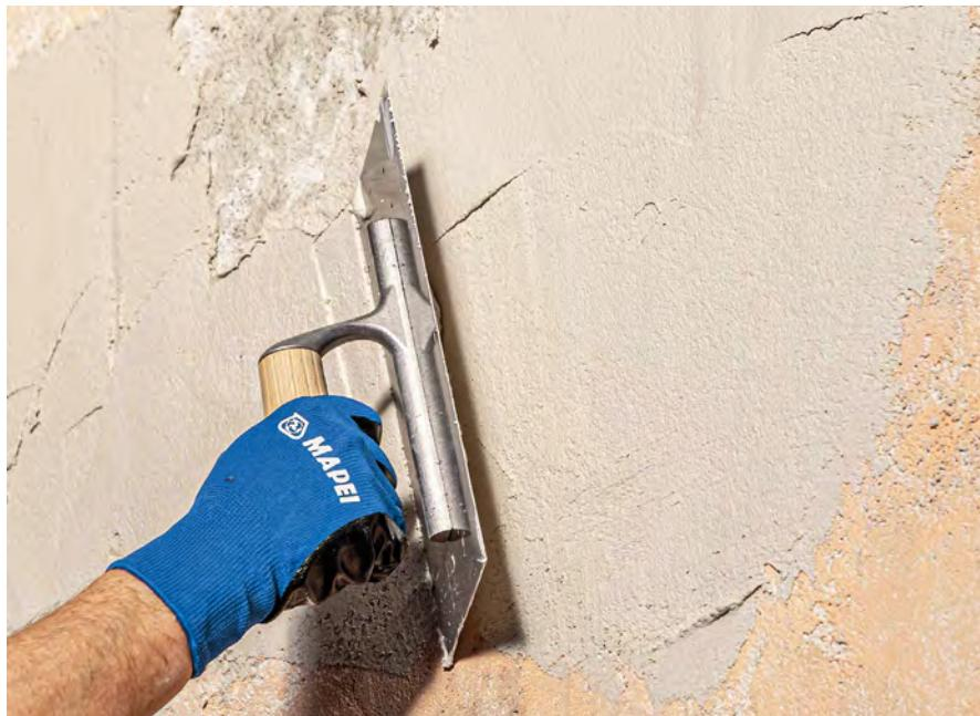
**Der Mehrzweckmörtel Mape-Antique NHL ECO Restaura wurde für die Wiederherstellung und den Ausgleich von Untergründen entwickelt.**
