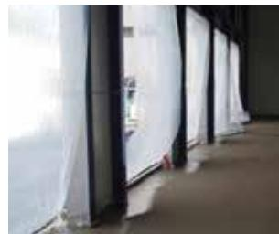
Dekke til åpninger og sørge for høy relativ fuktighet ved utstøpning. RF > 70%. Der luftfuktigheten ikke kan oppnås, må det benyttes herdemembran etter legging.
