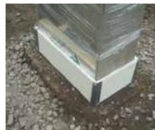
Korrekt montering av fleksibelt materiale rundt søyler og fasstholdingspunkt.
