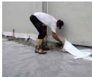
Hindre fastholding og tillate bevegelse mot yttervegger og andre kontaktflater.
