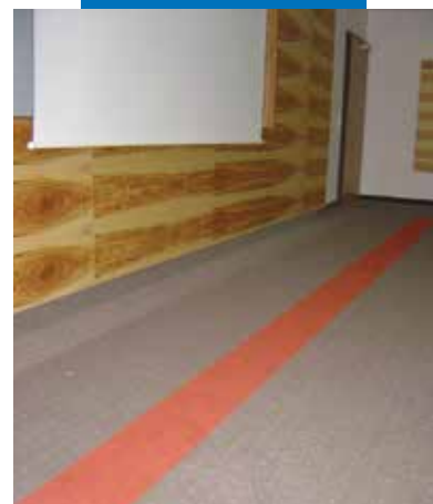
Näide Primer G kasutamisest enne liimi Ultraplan Eco ja Rollcoll pinnalekandmist, mida kasutatakse vaipade liimimiseks. cVilla Hotel Castellani – Austria, hotellituba.
