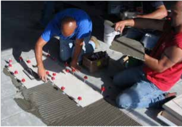
Figure 3 : Exemple de carreaux minces installés sur des carreaux existants à l'aide d'un système de nivellement mécanique
