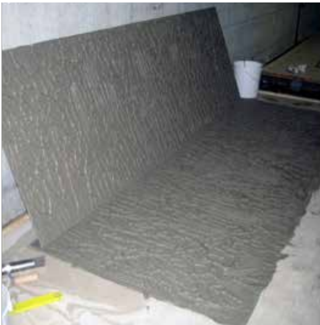
Figure 4 : Exemple de carreaux de porcelaine mince avec un transfert de ciment-colle maximal entre le carreau et le support
