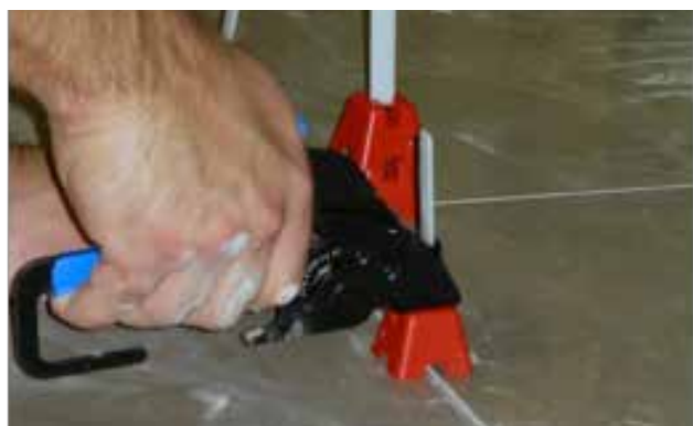
Figure 2 : Exemple de carreaux minces installés avec un système de nivellement mécanique pour réduire le gauchissement
