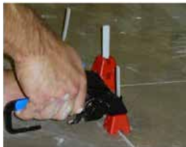
Exemple de carreaux calibrés installés à l'aide d'un système de nivellement mécanique pour réduire la balèvre.
