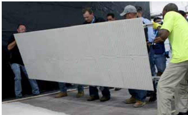
Exemple de panneau/dalle de carreau de porcelaine calibré avec couverture de ciment-colle maximale
