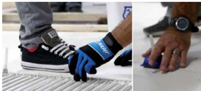
Exemple de carreaux calibrés installés sur des carreaux existants à l'aide d'un système de nivellement mécanique lors de travaux
