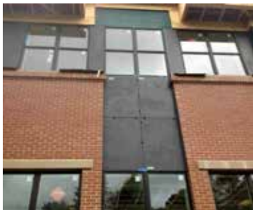
Panneau/dalle de carreau de porcelaine calibré sur une façade extérieure
