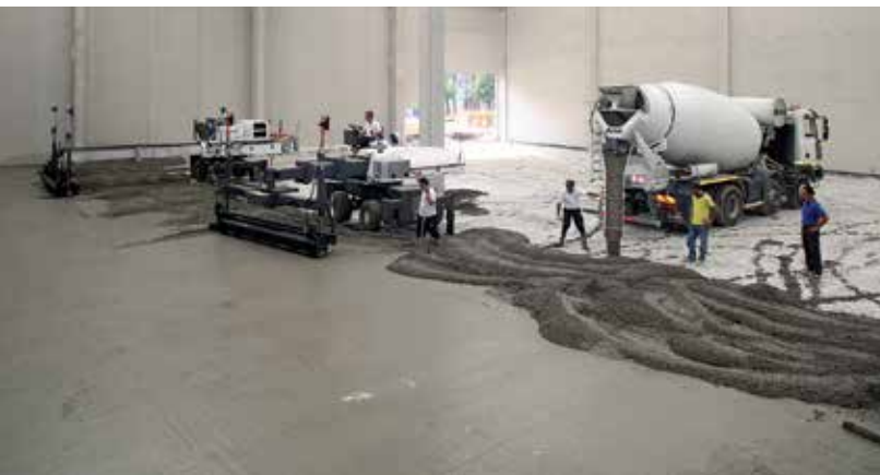
plancher de béton
