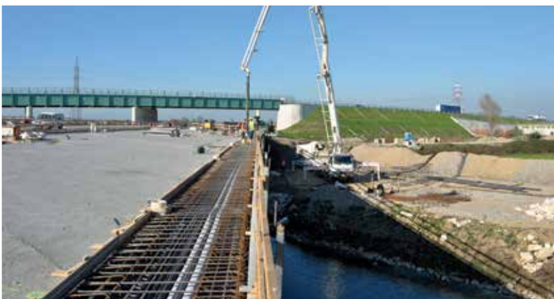
poutre de rive
