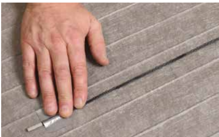
Fixer la sonde de détection du plancher
