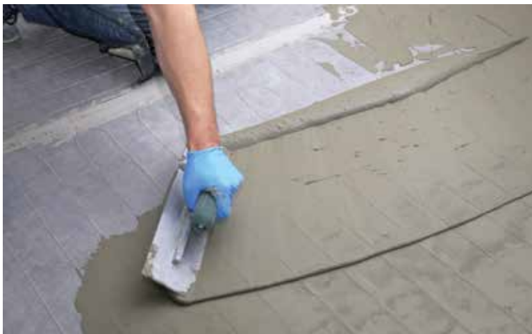
Poser le revêtement de sol en carreaux/pierre
