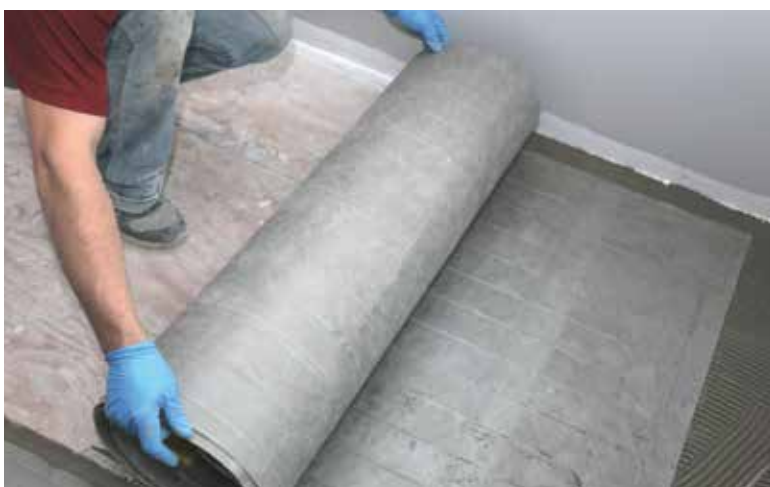
Dérouler Mapeheat Mat sur le ciment-colle frais
