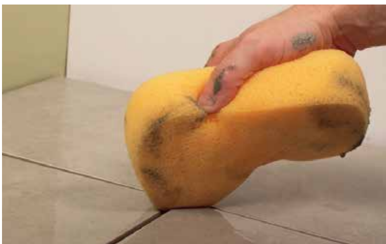
Nettoyer les joints de coulis
