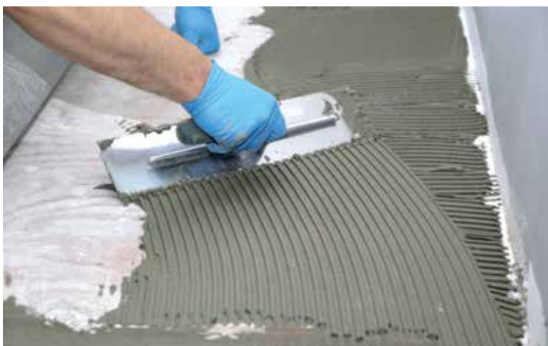
Appliquer le ciment-colle à la truelle
