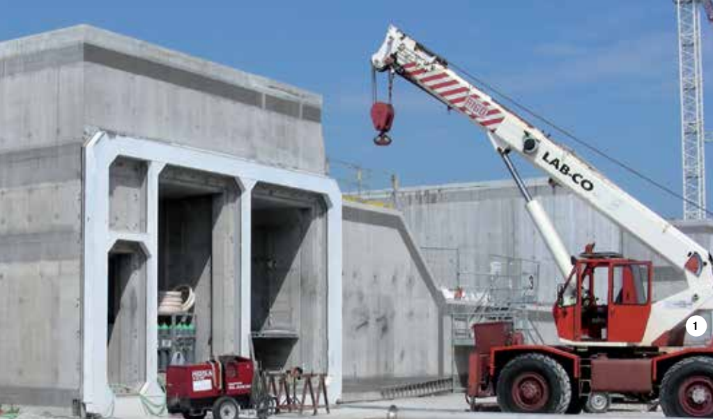
1. Caissons en béton armé utilisés dans le cadre du projet MOSE lors de leur fabrication. Les boîtiers de jonction des caissons ont été reliés entre eux par un système de jointolement constitué de Mapefill MF 610 . 2. Préparation et mise en place des coffrages sur les caissons avant le pompage de Mapefill MF 610 .
