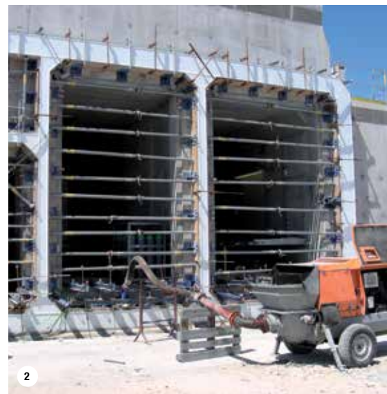
1. Caissons en béton armé utilisés dans le cadre du projet MOSE lors de leur fabrication. Les boîtiers de jonction des caissons ont été reliés entre eux par un système de jointolement constitué de Mapefill MF 610 . 2. Préparation et mise en place des coffrages sur les caissons avant le pompage de Mapefill MF 610 .
