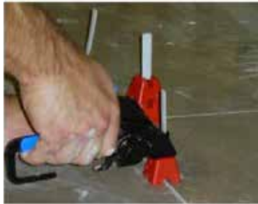
Ejemplo de loseta calibrada siendo instalada usando un sistema mecánico de nivelación de bordes para eliminar las diferencias de nivel entre bordes
