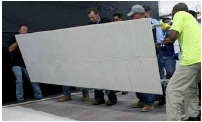
Ejemplo de panel/losa de loseta de porcelana calibrada con cobertura total de mortero
