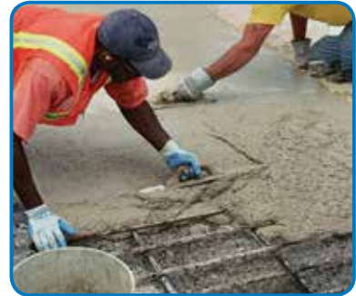
Morteros de reparación de concreto
