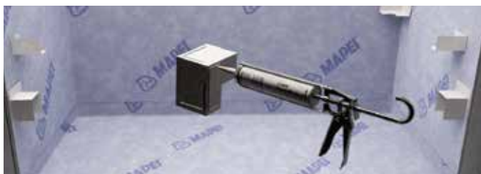
Figura 12: Adhiera las esquinas preformadas, la cubierta de bordillo en forma de U y los traslapes de 5 cm (2 pulgadas) usando el sellador híbrido ShowerPerfect
