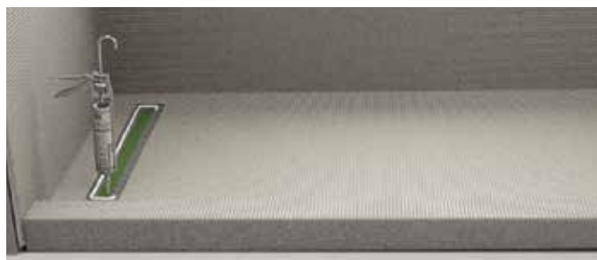
Figura 9: Aplique una solo cordón del sellador híbrido ShowerPerfect al perímetro del cuerpo del drenaje lineal.
