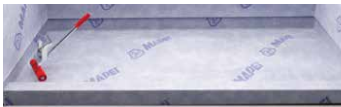
Figura 11: Use un rodillo de piso de vinilo para eliminar las arrugas o burbujas en Mapelastic WSM .
