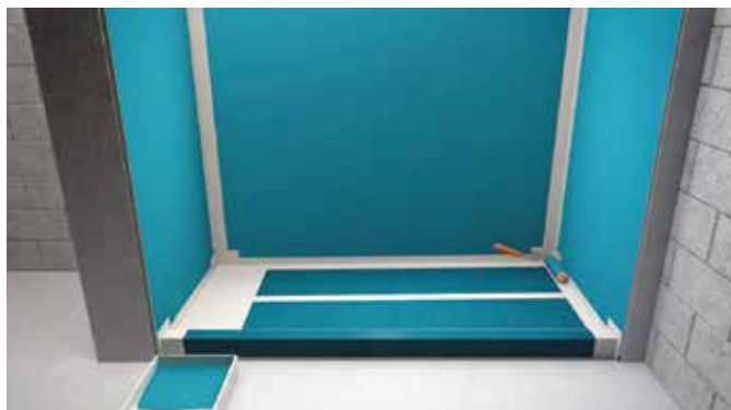
Figura 15: Aplicación de Reinforcing Fabric y ShowerPerfect LM en las esquinas interiores con Mapelastic AquaDefense de MAPEI
