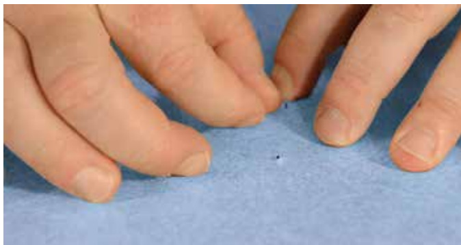
Figura 10: Posicione Mapelastic WSM sobre las clavijas localizadoras del cuerpo del drenaje lineal.
