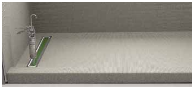
Figura 11: Aplique un solo cordón del sellador híbrido ShowPerfect al perímetro del cuerpo del drenaje lineal.
