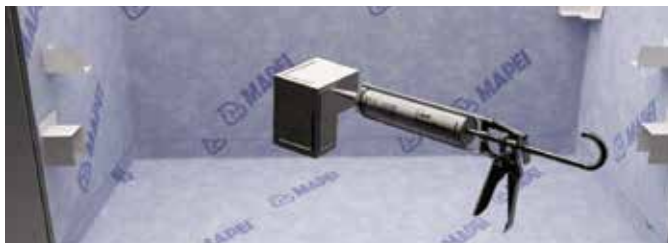
Figura 14: Adhiera las esquinas preformadas, la cubierta de bordillo en forma de U y los traslapes de 5 cm (2 pulgadas) usando el sellador híbrido ShowPerfect
