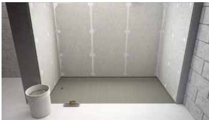
Figura 6: MAPEI Ultraflex RS usado para instalar la base de pendiente previa y el soporte del montaje de drenaje ShowerPerfect
