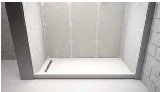
Figura 7: Bases de pendiente previa y soporte del montaje de drenaje ShowerPerfect instalado y listo para el siguiente paso
