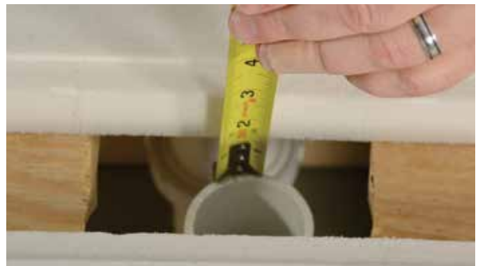
Figura 5: Mida desde la ranura rebajada hasta la parte superior de la “tubería saliente”.
