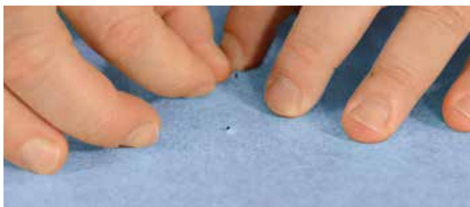
Figura 12: Posicione Mapelastic WSM sobre las clavijas localizadoras del cuerpo del drenaje lineal.
