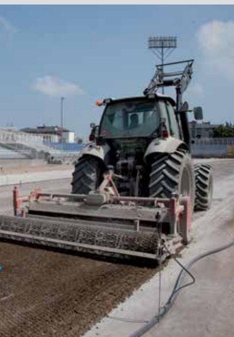
Mezcla de Mapesoil 100 con agregado
