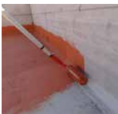
Aplicación de la membrana
