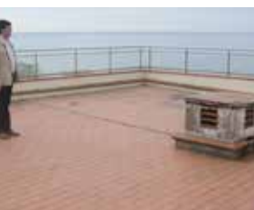
Preparación de la superficie
