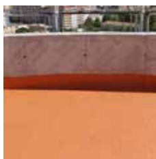
Finalizado de la aplicación
