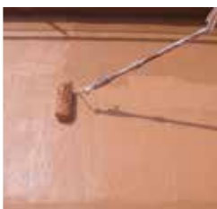
Imprimación con el mismo producto diluido al 10% con agua
