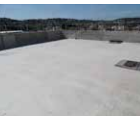
Preparación de la superficie
