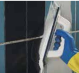
Aplicación de Kerapoxy CQ con espátula Mapei en pared
