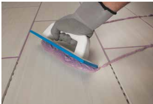
Aplicación de Kerapoxy CQ con espátula Mapei
