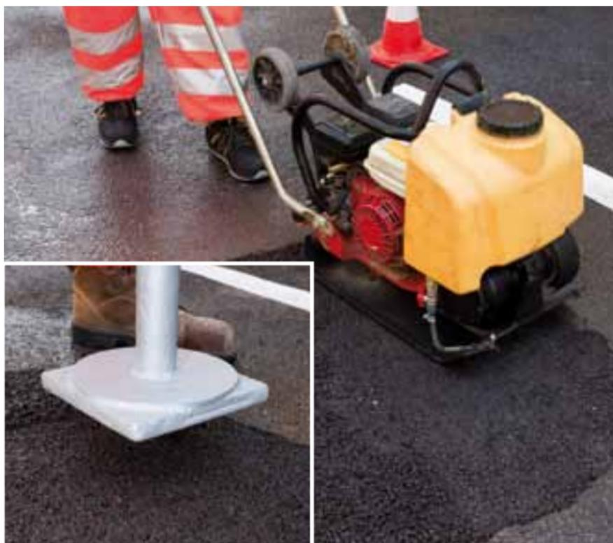
4. Compactación manual o mecánica de **Mape-Asphalt Repair 0/8**
