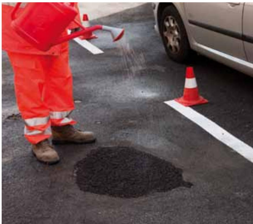
3. Humectación de la superficie de **Mape-Asphalt Repair 0/8**
