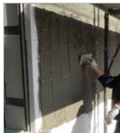
Fig. 5.9 – Extensión mediante llana metálica
