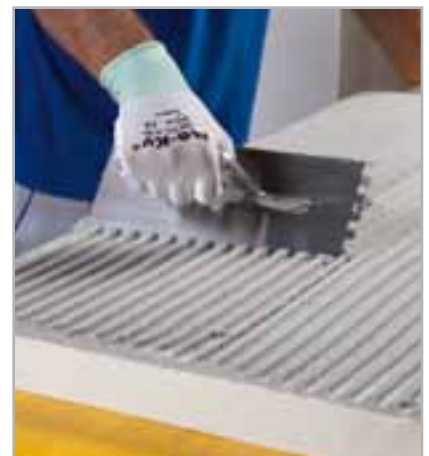
Fig. 5.3 – Aplicación del adhesivo sobre el dorso del panel
