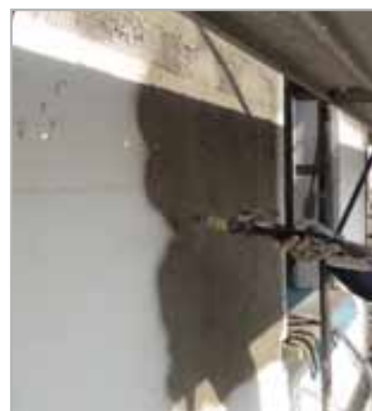
Fig. 5.8 – Aplicación de PLANITOP HDM MAXI a máquina
