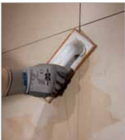
Fig. 5.19 – Rejuntado con ULTRACOLOR PLUS
