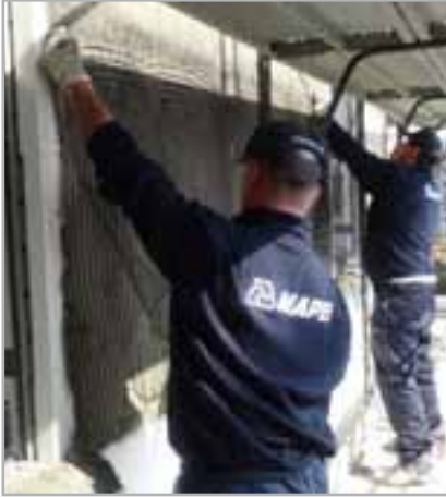
Fig. 5.10 - Colocación de la armadura MAPEGRID G 120
