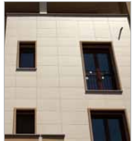
Fig. 3.2 - Edificio residencial revestido con MAPETHERM TILE SYSTEM
