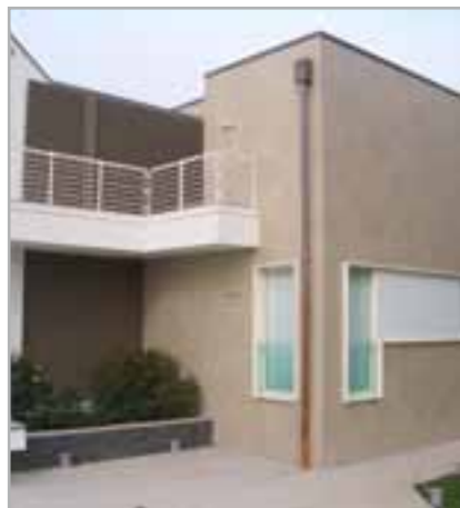
Fig. 1.1 - Edificio residencial revestido con MAPETHERM TILE SYSTEM
