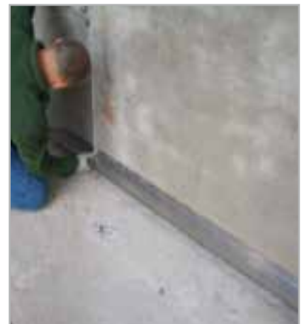
Fig. 5.2 - Colocación del perfil de partida MAPETHERM BA
