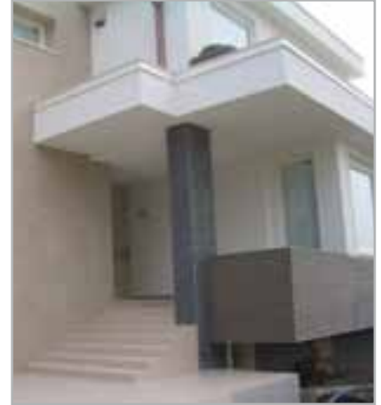
Fig. 3.1 - Edificio residencial revestido con MAPETHERM TILE SYSTEM
