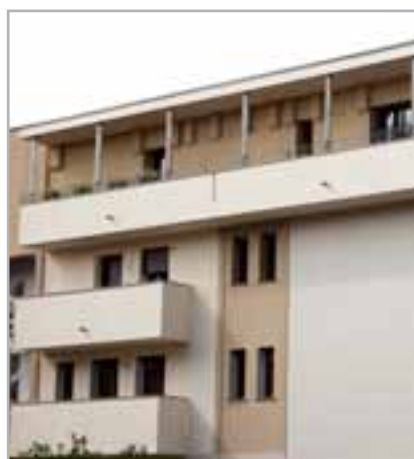
Fig. 1.2 - Edificio residencial revestido con MAPETHERM TILE SYSTEM
