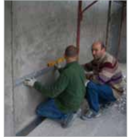
Fig. 5.1 – Verificación de la planitud del soporte
