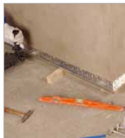
Fig. 4.16 – Posicionamiento de los perfiles MAPETHERM BA
