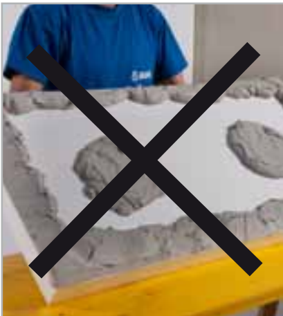
Fig. 5.5 – Aplicación incorrecta del adhesivo en cordón y puntos
