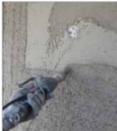
Fig. 5.13 - Aplicación a máquina de la segunda capa de PLANITOP HDM MAXI
