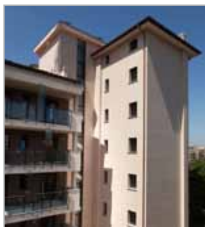
Fig. 1.3 - Edificio residencial revestido con MAPETHERM TILE SYSTEM
