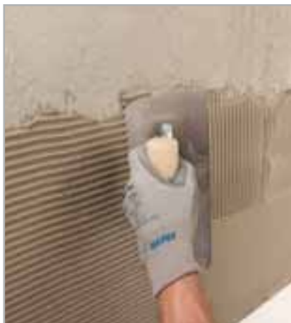
Fig. 5.17 – Aplicación de ULTRALITE S2 sobre revoque estructural PLANITOP HDM MAXI
