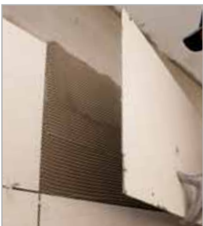
Fig. 5.18 – Colocación de baldosas de gres porcelánico con el método del doble encolado
