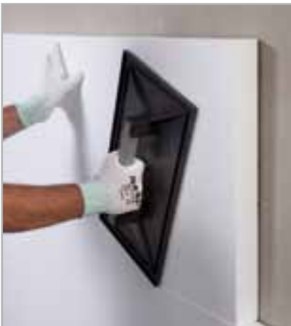
Fig. 5.6 – Puesta en obra del panel
