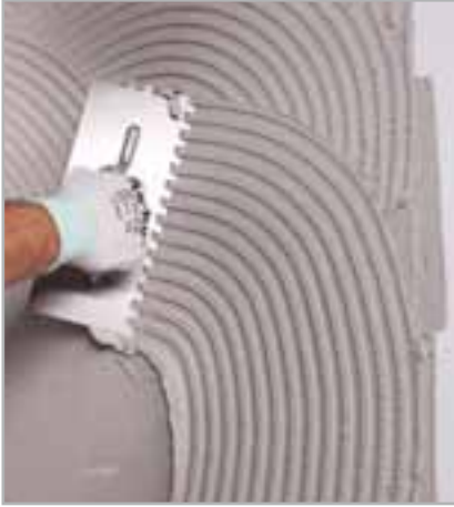
Fig. 5.4 – Aplicación del adhesivo sobre el soporte
