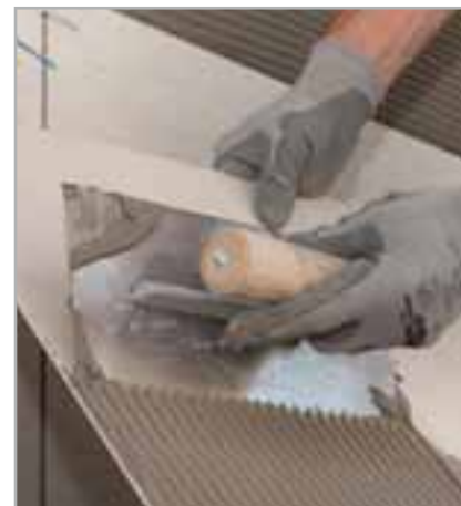
Fig. 5.16 – Aplicación de ULTRALITE S2 sobre el dorso de las baldosas de gres porcelánico
