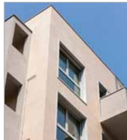
Fig. 3.3 - Edificio residencial revestido con MAPETHERM TILE SYSTEM
