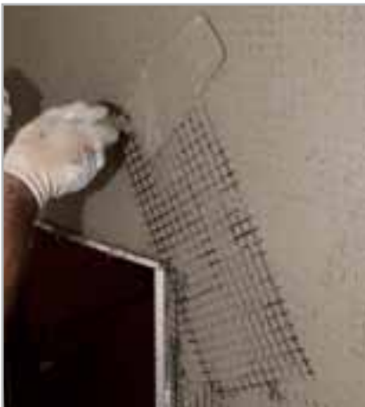
Fig. 5.11 - Colocación de partes de MAPEGRID G 120 en correspondencia con los ángulos de las aperturas
