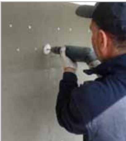
Fig. 5.12 - Aplicación de MAPETHERM TILE FIX 15
