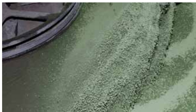
Aplicación manual del Mapetop N AR6
