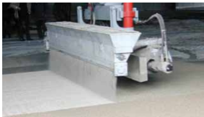
Aplicación mecánica del Mapetop N AR6
