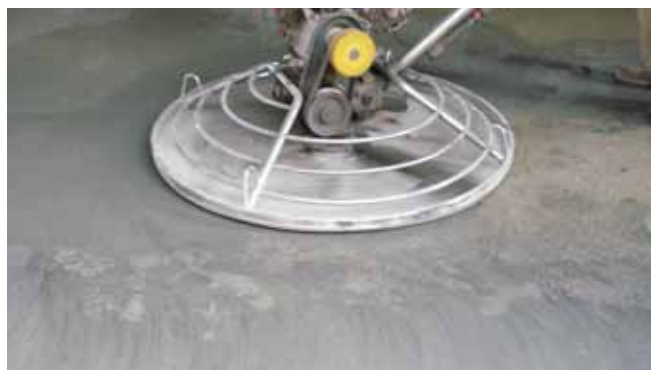
Fratasado mecánico con helicóptero
