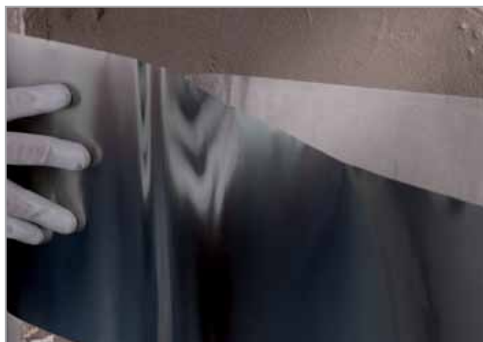
Aplicación de Mapeshield E 25 sobre la superficie externa de la estructura
