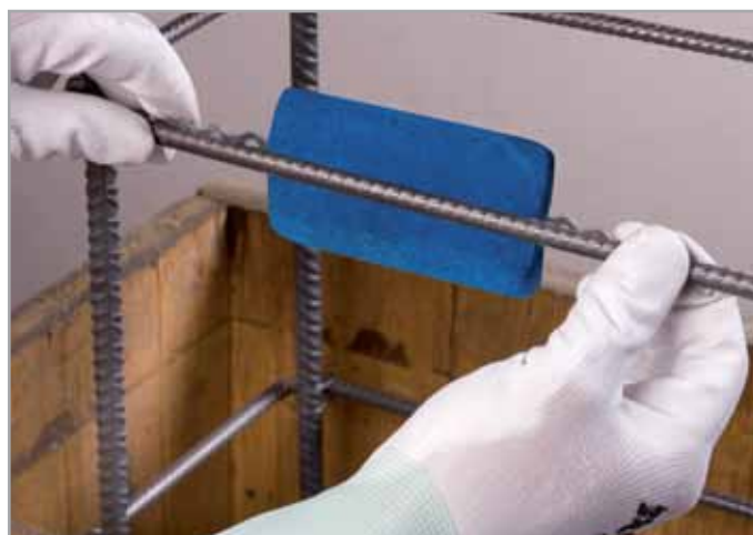
Aplicación de Mapeshield I sobre una estructura de nueva construcción
