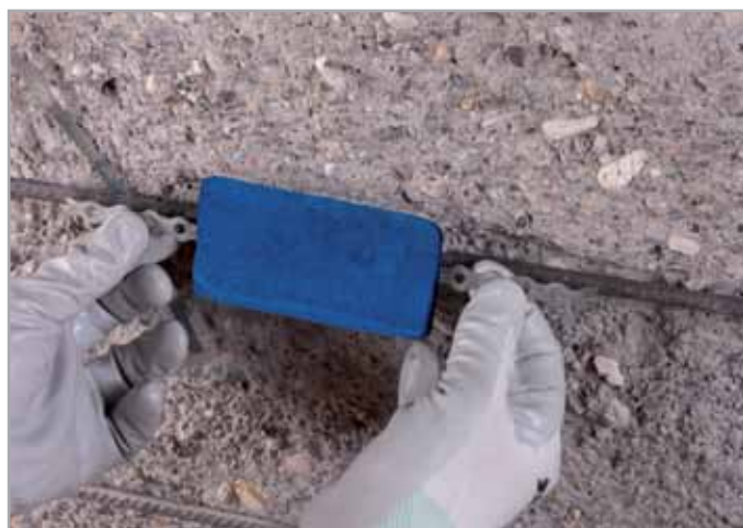
Aplicación de Mapeshield I sobre una estructura a rehabilitar
