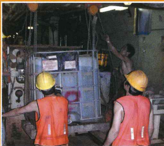
Cambio de cisterna del producto acondicionante del terreno POLYFOAMER FP para los trabajadores de TBM
