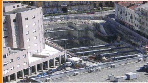
Obra en Oporto Metro de Oporto, estación Heroísmo Empresa Soares Costa Productos utilizados: MAPEQUICK AF 400 y DYNAMON SX
