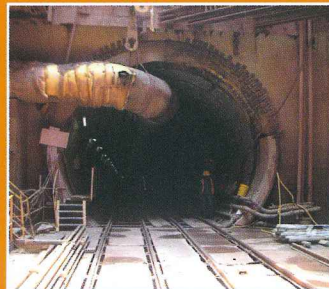
Boca sur de la galería excavada con EPB TBM. La eficiencia en el avance de la fresa ha sido posteriormente mejorada con el uso de productos MAPEI, para el acondicionamiento del terreno POLYFOAMER FP y FOAMER 300
