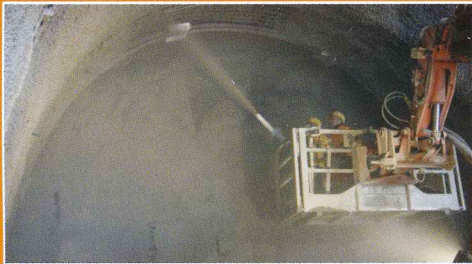
Obra en Dortmund Bundestrasse B236, Empresa Bilfinger y Berger Productos utilizados: MAPEI DYNAMON SX y MAPEQUICK AF D 03
