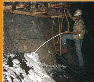
Boca norte de la galería. El responsable de la TBM controla la calidad de la espuma a través del sistema de inyección lateral. La foto recoge la espuma producida con el uso de productos MAPEI para el acondicionamiento del terreno POLYFOAMER FP y FOAMER 300
