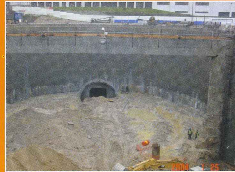
Obra en Oporto Metro de Oporto, estación Salgueiros Empresa Somague y Tecnasol Productos utilizados: MAPEQUICK AF 1000 y DYNAMON SX
