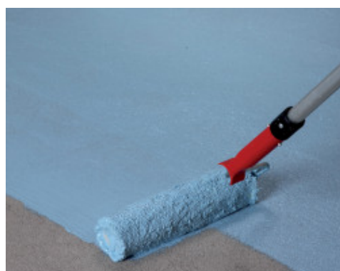
Aplicación de la primera capa de Mapelastic AquaDefense sobre una carpeta
