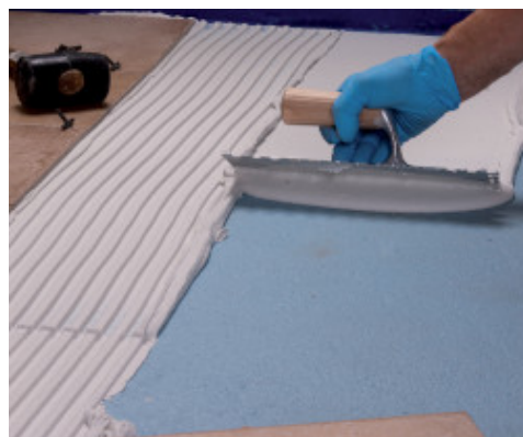
Colocación de cerámica sobre Mapelastic AquaDefense
