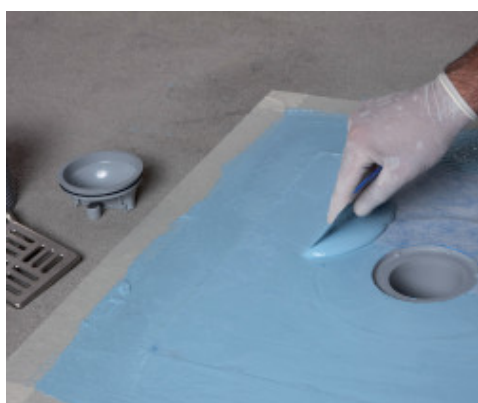
Impregnación del tejido Drain Vertical con Mapelastic AquaDefense
