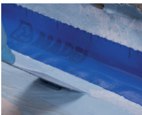
Aplicación de Mapeband en la unión pared-piso con Mapelastic AquaDefense
