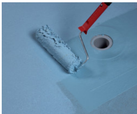
Aplicación con rodillo de la segunda capa de Mapelastic AquaDefense
