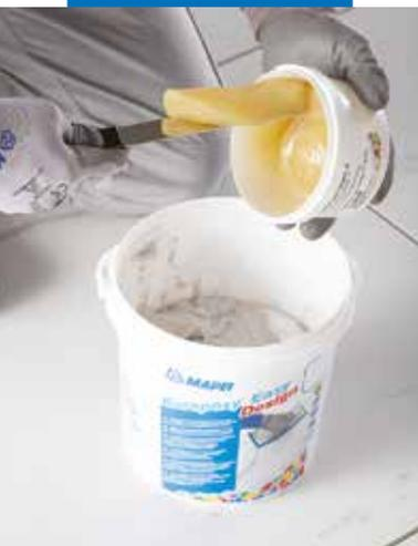
Versare l'induritore (componente B) nel contenitore del componente A
