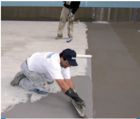
Impermeabilización de una piscina con Mapelastic
