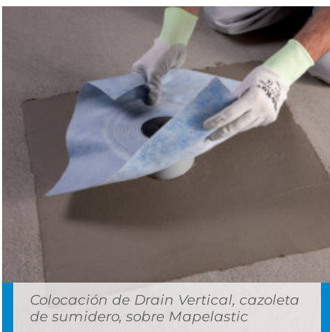
Impermeabilización del contrapiso/carpeta con Mapelastic y Mapeband
