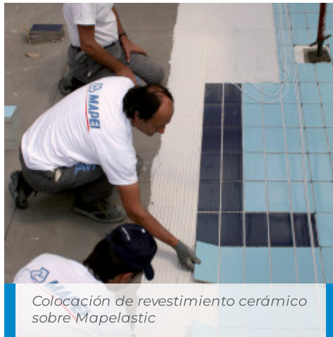
Piscina impermeabilizada con Mapelastic - Piscina Scarioni (Milán) Italia
