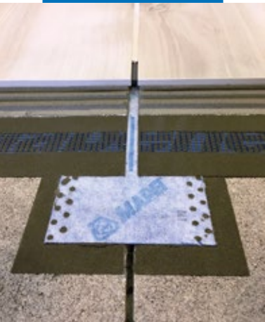
Mapeband Easy aplicado sobre una junta de control en el concreto.
