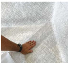
Por outro lado, as **uniões entre fins de rolos** ou em **cantos e arestas** são efetuadas com a fita **Mapeproof FBT Tape 600** para criar juntas completamente estanques.
