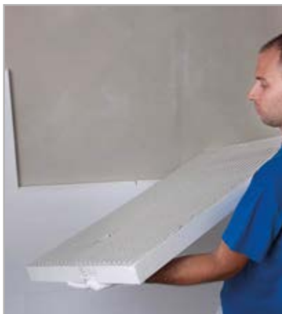
Fig. 6.7 - Aplicação dos painéis com junta intercalada
