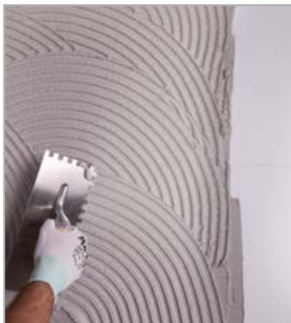
Fig. 6.11 - Realização da primeira demão do barramento
