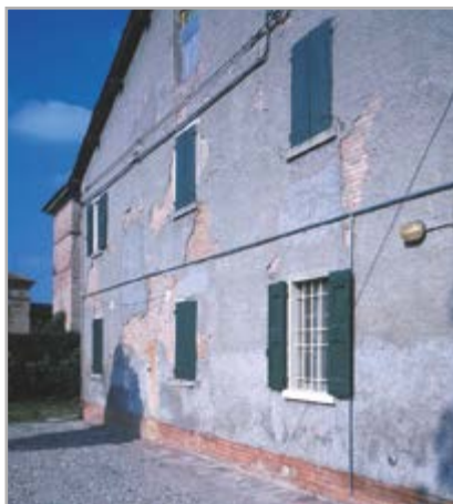
Fig. 6.2 - As partes do reboco em fase de destacamento devem ser removidas antes da colagem dos painéis termo isolantes
