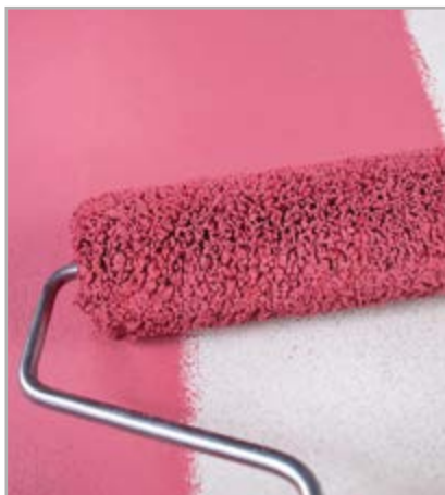
Fig 6.14 - Aplicação do primário pigmentado
