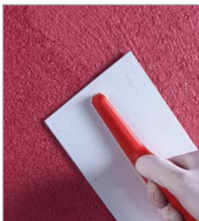
Fig 6.16 - Acabamento do tonachino com talaocha de plástico
