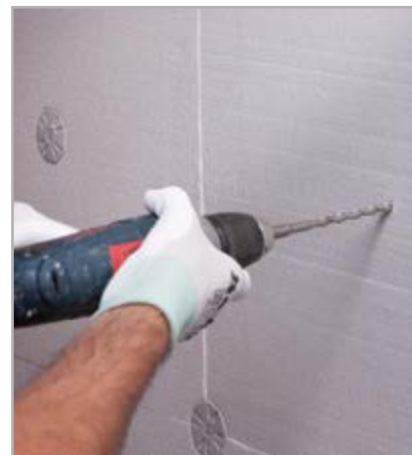
Fig. 6.9 - Realização do furo para inserir a bucha
