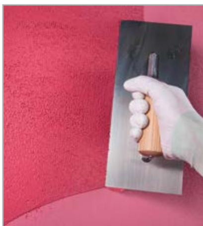
Fig 6.15 - Aplicação do tonachino de acabamento
