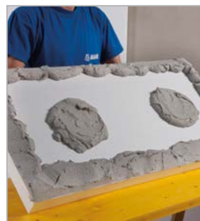
Fig. 6.6 - Distribuição por cordão perimetral e pontos centrais do adesivo sobre o reverso do painel termo isolante
