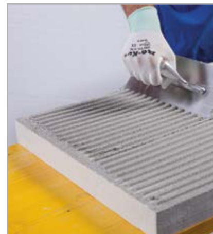
Fig. 6.5 - Distribuição homogênea do adesivo sobre o reverso do painel termo isolante
