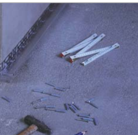
Fig. 6.4 - Fixação do perfil inicial usando uma bucha de expansão
