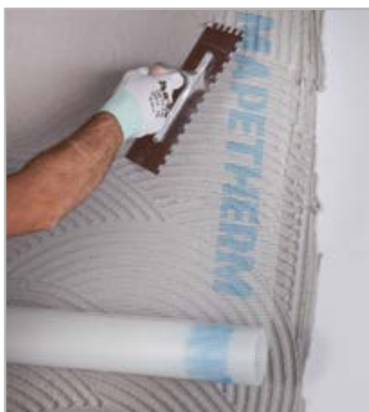
Fig. 6.12 - Colocação em obra de MAPETHERM NET
