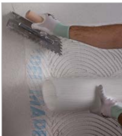
Fig. 6.13 - Sobreposição das telas de rede por pelo menos 10 cm
