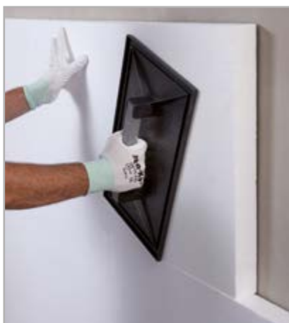
Fig. 6.8 - Pressão sobre o painel com talocha
