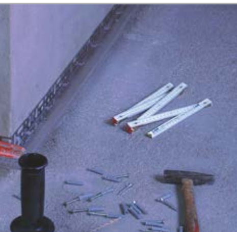
Fig. 6.3 - Posicionamento do perfil inicial: garante uma perfeita horizontalidade usando um nível de bolha
