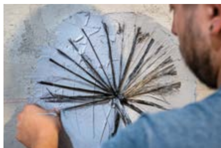
Aplicação do conector MapeWrap C Fiocco. Application of MapeWrap C Fiocco connector.
