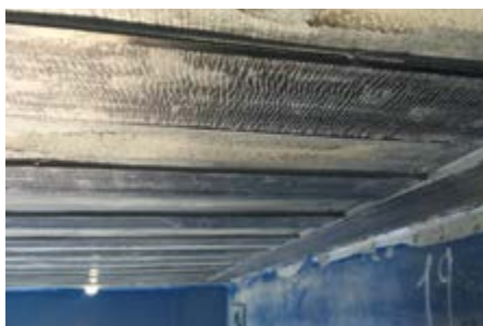
Aplicação de lâminas de carbono pultrudidas. Application of pultruded carbon fibre plates.
