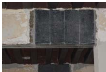
Reforço de vigas com tecido em carbono.
