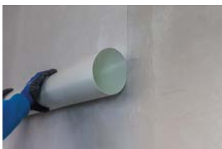
Aplicação do tecido de vidro bidirecional. Application of bi-directional glass fibre fabric.
