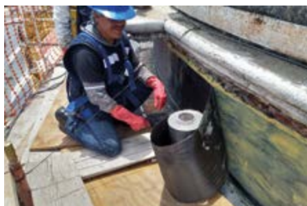
Aplicação de tecido em fibra de carbono. Application of carbon fibre fabric.
