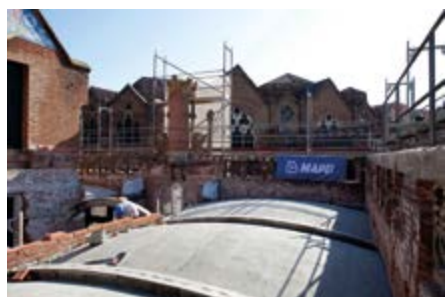
Aplicação da tecnologia FRCM System sobre as abobadas.
