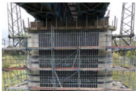
Reforço com lâminas e tecidos de carbono. Strengthening work with carbon plates and fabric.
