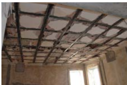
Reforço de lajes de pavimento com chapas de carbono.
