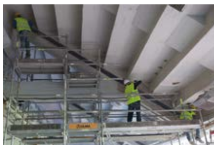
Colocação de chapas de carbono em vigas. Installation of carbon fibre plates on beams.
