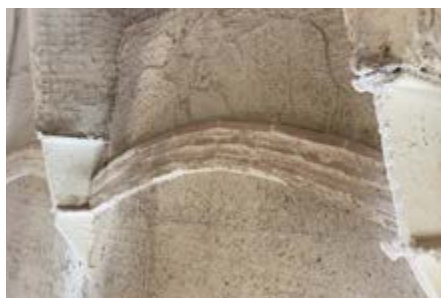
Reforço em FRCM System para alvenaria de suporte de escadas.
