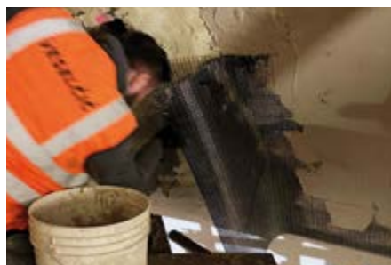
Aplicação da rede em fibra de vidro.
