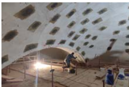
Reforço de arcos e abóbadas no intradorso.
