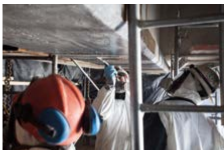
Aplicação de resinas epóxi. Application of epoxy resins.
