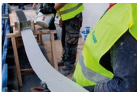
Aplicação de resina epóxi em lâmina de carbono. Application of epoxy resin on a carbon fibre plate.
