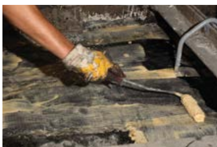
Aplicação de reforço FRP System em abóbadas. Application of FRP System to strengthen a vaulted ceiling.
