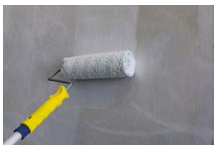
Aplicação de adesivo em dispersão de poliuretano. Application of adhesive in polyurethane dispersion.
