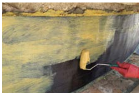
Aplicação de adesivo epóxi tixotrópico. Application of thixotropic epoxy adhesive.
