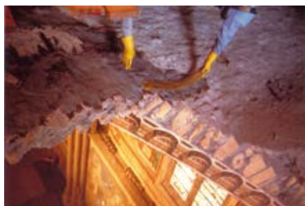
Reforço extradossal da abóbada com FRP. Extradossal strengthening of the vault with FRP.
