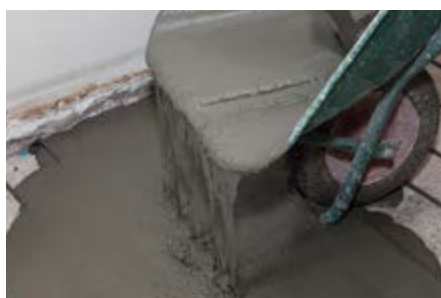
Reforço de lajes com Planitop HPC Floor.
