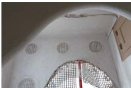
Reforço interno de alvenaria com FRCM System e ligações Fiocco FRP.
