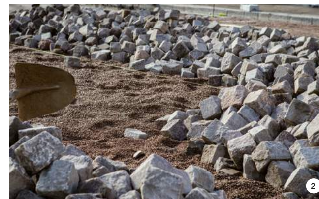
2. Os cubos escarificados do pavimento anterior, limpos e polidos, prontos para serem assentados para a nova pavimentação.
