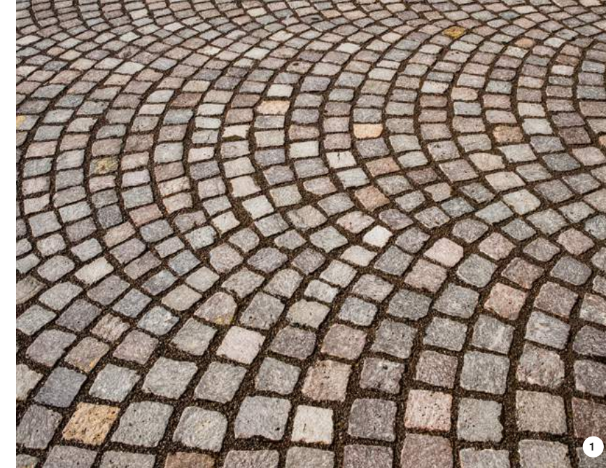
1. Pormenor do novo pavimento em cubos de pórfiro, com as juntas enchidas com pórfiro triturado ligado por MAPESTONE JOINT, resina de poliuretano isenta de solventes.
