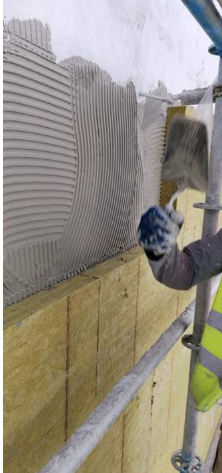
Vários ângulos da fachada isolada com o sistema Mapetherm
