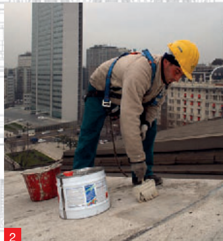
Foto 1. Sigillatura monolitica dei blocchi con Mapesil BM.
