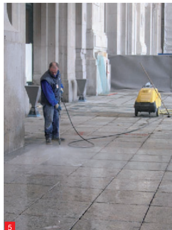
Foto 4. Stuccatura della pavimentazione con sabbia vagliata VA.GA.
