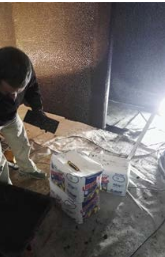
FOTO 6. Betumação das pastilhas de vidro com ULTRACOLOR PLUS.
